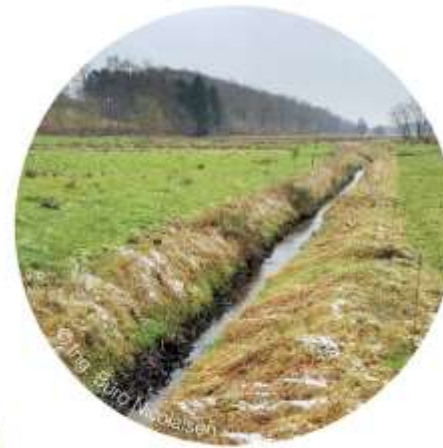
Vorher: Durch Ausbau und Begradigung der Kleinen Hüttener Au sollte das überschüssige Wasser besser und schneller aus den landwirtschaftlich genutzten Flächen abfließen.
